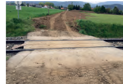
ABBAU von Eisenbahnkreuzungen
