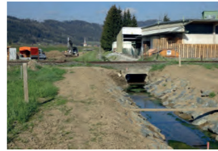
FERTIGSTELLUNG DER PENKENBACHVERBAUUNG – Instandsetzung des Bahndurchlasses und der Abdeckung im Park
