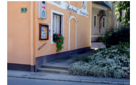
ERNEUERUNG DER STIEGE beim Fußweg zur Pfarrkirche Weißkirchen
