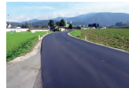
ASPHALTIERUNGEN im Bereich der Gaberbundesstraße
