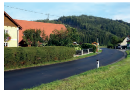
ASPHALTIERUNG in Großfeistritz
