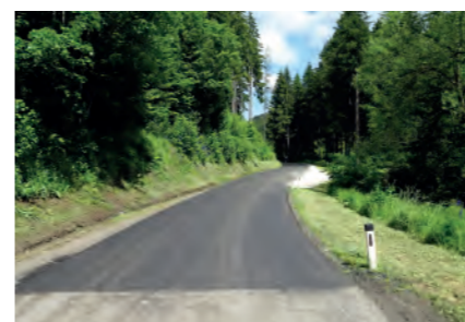
ASPHALTIERUNGEN nach Kleinfestritz
