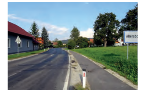
ASPHALTIERUNG im Ortsgebiet Allersdorf
