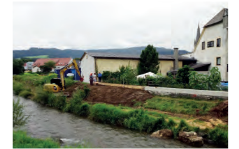
GRANITZENBACH Erhöhung der Ufermauer im Bereich Polster - Apfelknab
