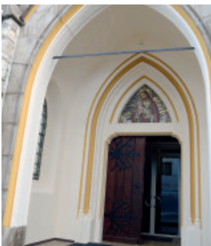
Die Sanierung des KIRCHENPORTALS der Pfarrkirche Weißkirchen wurde unterstützt
