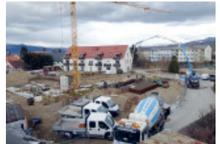
Baubeginn beim ROTTENMANNER-HAUS in Weißkirchen
