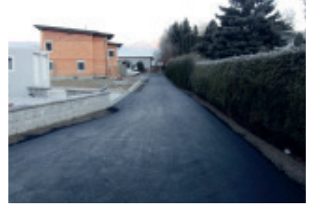
Asphaltierung des FAUSTMANNWEGES in Pichling
