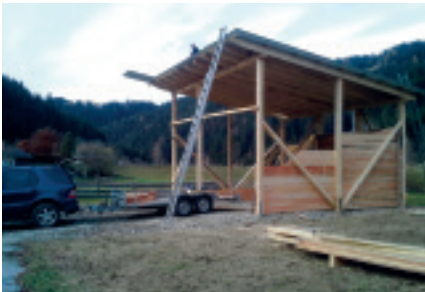
Errichtung einer SPLITTHÜTTE in Kleinfestritz
