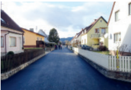
NEUASPHALTIERUNG der Baumkirchnersiedlung in Weißkirchen
