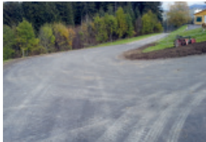
Erneuerung der „BRANDNER-KURVE“ in Schobergg
