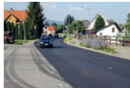
ASPHALTIERUNG der L 537 im Bereich Fisching
