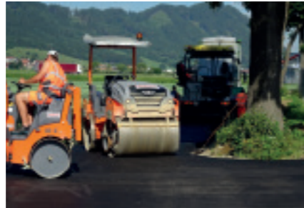
ERRICHTUNG eines Geh- und Radweges beim Sportplatz Weißkirchen
