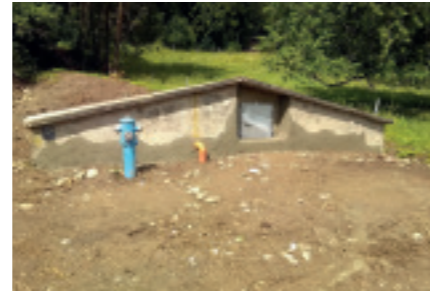
SANIERUNG des Hochbehälters in Wöllmerdorf
