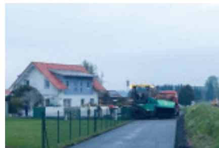
ASPHALTIERUNG des Ahornweges
