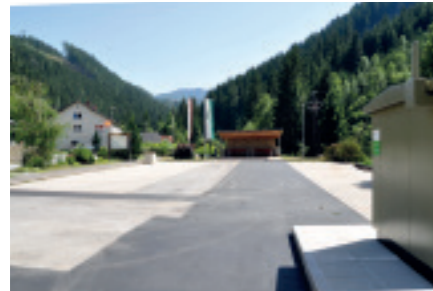
SANIERUNG des Dorfplatzes in Kleinfeistritz
