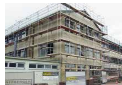
BAUABSCHNITT 02 der Thermischen Sanierung der NMS Weißkirchen
