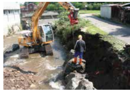
1. BAUMASSNAHMEN am Granitzenbach
