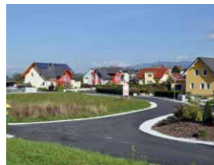
ASPHALTIERUNG der Reistenhofsiedlung in Weißkirchen
