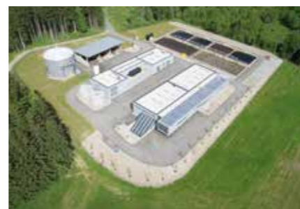
ERÖFFNUNG der neuen Verbandskläranlage in Zeltweg
