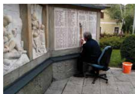
RENOVIERUNG des Kriegerdenkmals
