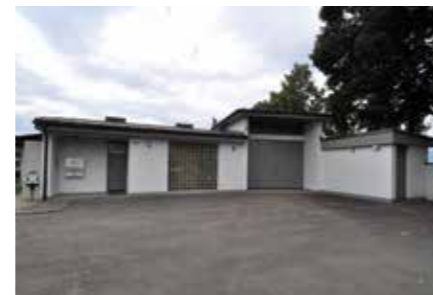
SANIERUNG der Aufbruchhalle
