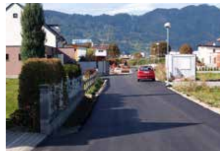
ASPHALTIERUNG der Zaunmüllergasse
