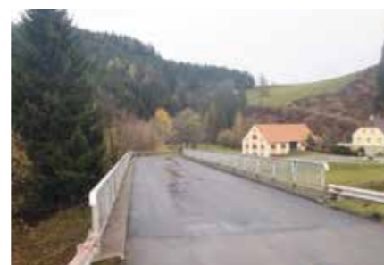
ASPHALTIERUNG der Schwarzenbachstraße
