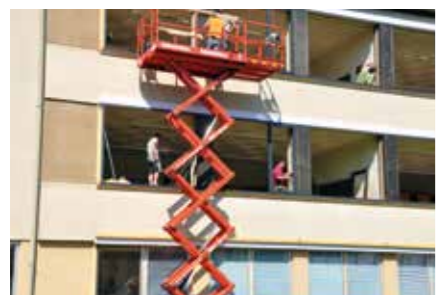
BAUABSCHNITT 01 der Thermischen Sanierung
