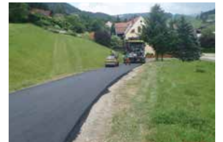
ERNEUERUNG des Weges nach Schoberegg
