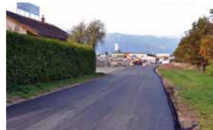
SANIERUNG der Bahnhofstraße in Weißkirchen
