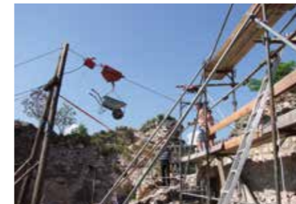
SANIERUNGSARBEITEN auf der Ruine Eppenstein
