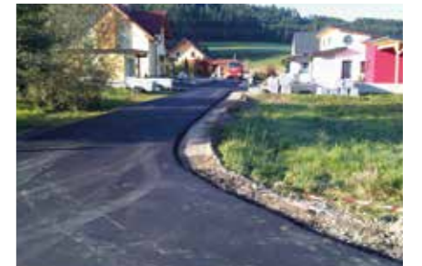
STRASSE ALLERSDORF SÜD
