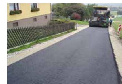
ASPHALTIERUNG des Leitenbauerweges
