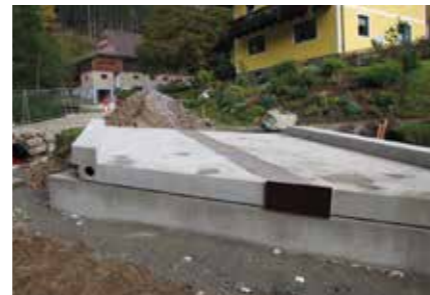
ERNEUERUNG der Hölltalbrücke
