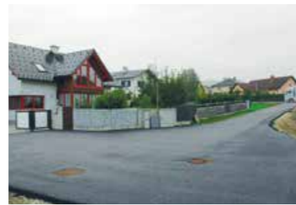
STRASSENERNEUERUNG in Unzdorf
