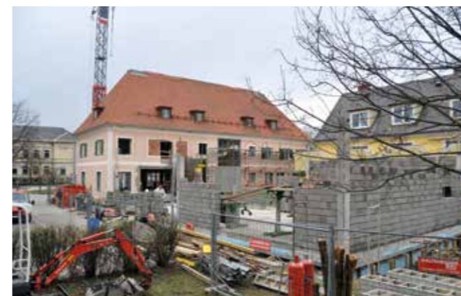
UM- UND AUSBAU des Weißkirchner Amtshauses
