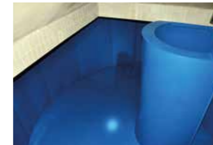
SANIERUNG DES HOCHBEHÄLTERS
