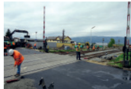
Sanierung des Bahnüberganges in Weißkirchen samt Mitverlegung von Leerverrohrungen
