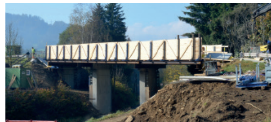
Ein sehr kostenintensives Vorhaben ist die Sanierung und Adaptierung der 1968 errichteten Schwarzenbachbrücke über die Eisenbahn.
