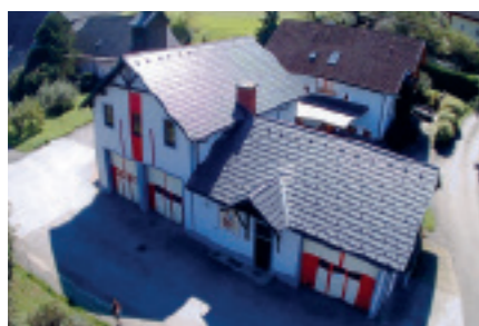
Dacherneuerung beim RÜSTHAUS BAIERDORF
