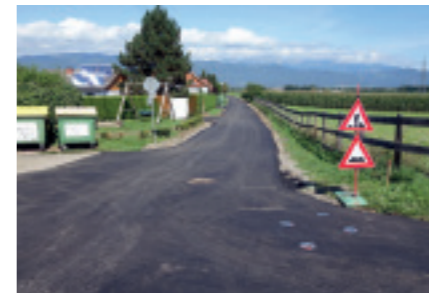
Die ZELLER KREUZ STRASSE erhielt einen neuen Asphaltbelag
