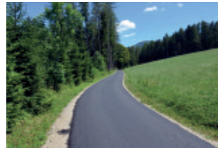
Asphaltierung des PAISBERGWEGES
