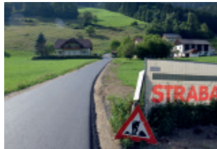
Übernahme und Asphaltierung des HABERLWEGES in Hintersieding
