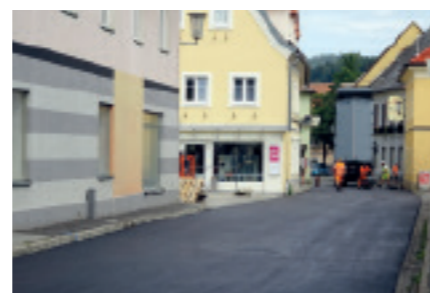
Neuasphaltierung der JUDENBURGER-STRASSE nach dem Leitungsschaden
