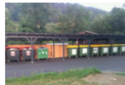
Erneuerung der MÜLLSAMMELSTELLE und des SÄTTLERWEGES in Eppenstein
