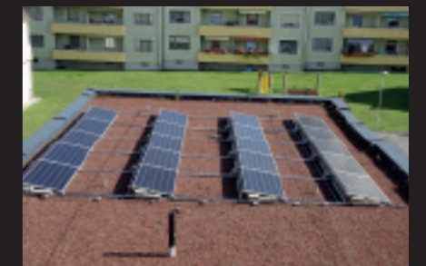
Am Dach des Gemeindesaales wurde eine PHOTOVOLTAIKANLAGE installiert, welche im Krisenfall die Stromversorgung gewährleisten soll.
