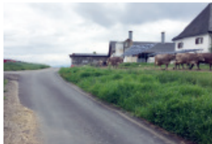
Eine Asphaltdecke erhielt der Weg LIEBMINGER - UNTERWIESER in Unzdorf
