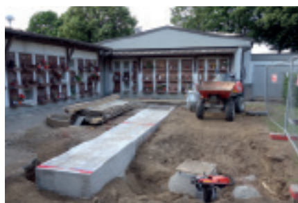
Errichtung der 4. URNENWAND am Friedhof Weisskirchen
