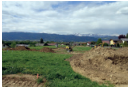
Aufschließung der WEILHARTER GRÜNDE in Unzdorf
