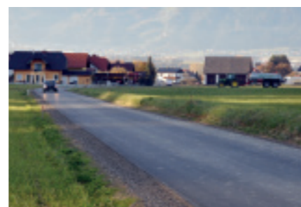
Asphaltierung der FARCHSTRAÙE
