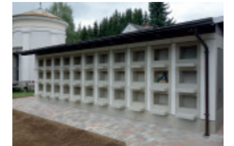
Errichtung der 4. Urnenwand am FRIEDHOF WEISSKIRCHEN
