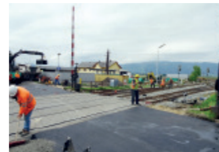
Die ÖBB sanierten den Bahnübergang Judenburgerstraße
