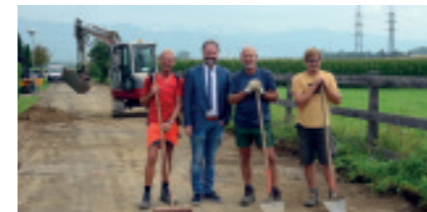
NEUASPHALTIERUNG der Zellerkreuzstraße
