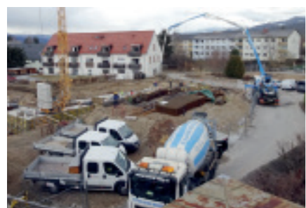
Die Rottenmanner-Baustelle mitten im Markt Weisskirchen
