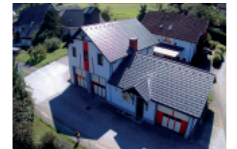
Ein neues Dach für das RÜSTHAUS BAIERDORF
