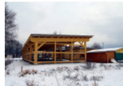
Der ESV WEISSKIRCHEN errichtete eine Überdachung
