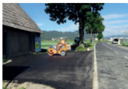
ERRICHTUNG DES GEHSTEIGES „Weißkirchen-West“
