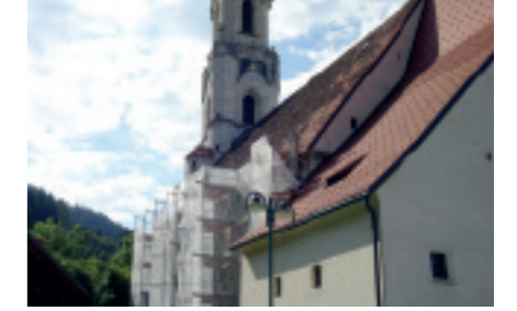
Die Wallfahrtskirche Maria Buch - Fassadensanierung
