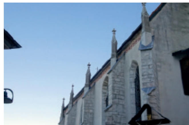
Sanierung Fialen - Wallfahrtskirche Maria Buch
