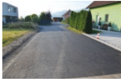
ASPHALTIERUNG Zufahrtsstraße Wielandsiedlung 30 – 37
