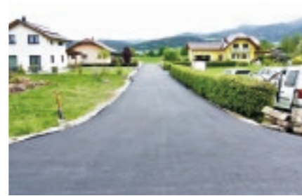
ASPHALTIERUNG Zufahrtsstraße Baierdorf 42 – 47
