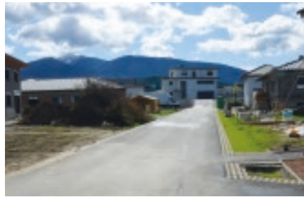
ASPHALTIERUNG Zufahrtsstraße Unzdorf 52 – 63
