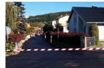
ASPHALTIERUNG & BELEUCHTUNG Langmühlbauerweg
